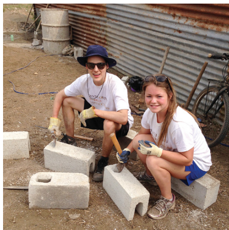
Keegan Marchand et Shelby Kieper préparent des blocs de bétons.
